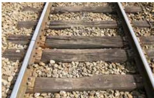
Rails courts sur traverses bois
