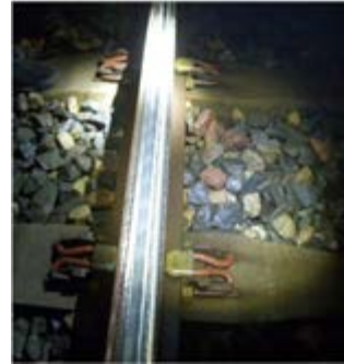
rail après meulage
