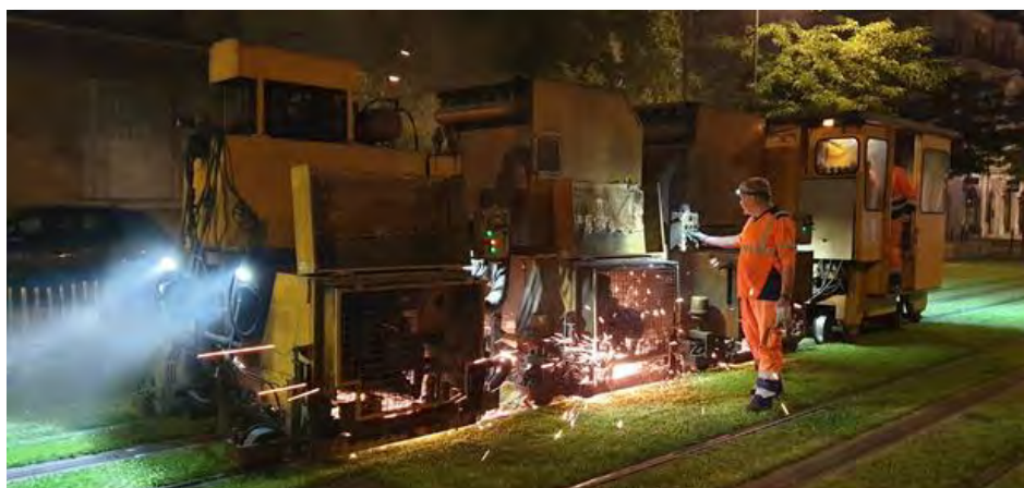
Train de meulage en action et rail après la réalisation du meulage
