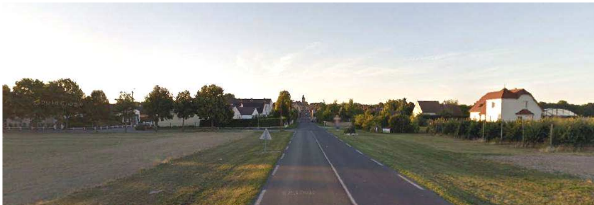
Vue depuis l'entrée Sud (source : Google Maps)
