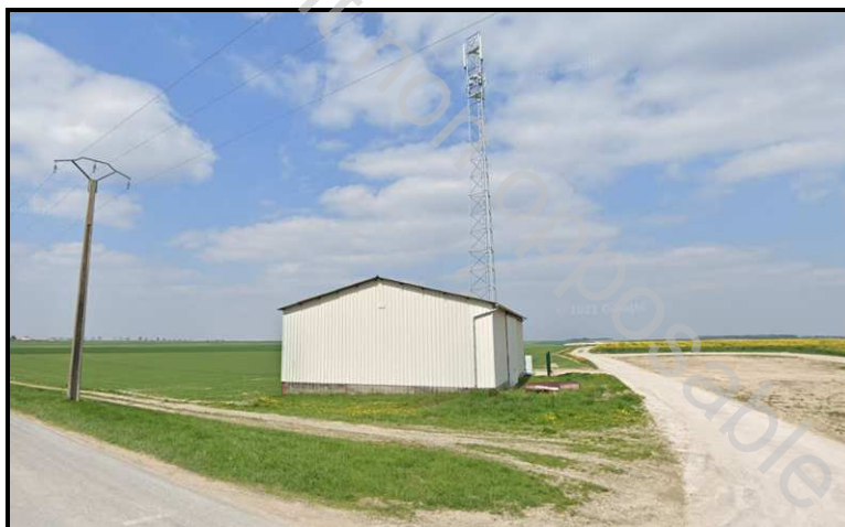
Pylône autostable existant de 36 m (ACT France – Orange) implanté entre Bourgogne et Fresne
