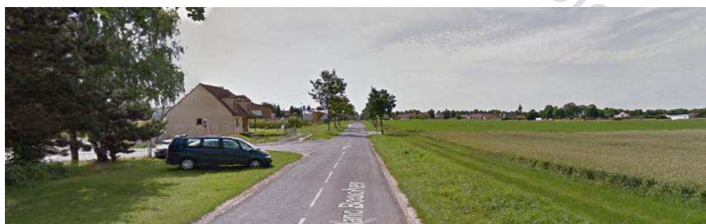
Vue générale sur le centre du village en face et pavillons en zone d'activité à gauche (source : Google Maps)
