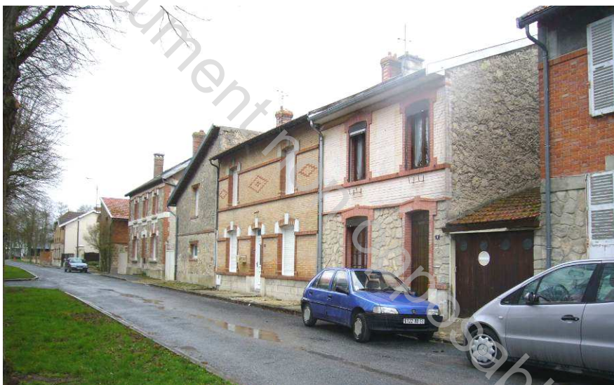
Bâti ancien rénové, avenue du Docteur Manichon
