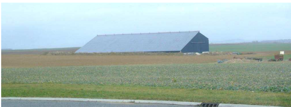
Hangar agricole à droite de la RD 374
