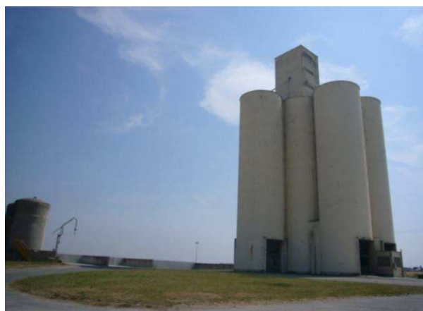
Silo en entrée de ville
