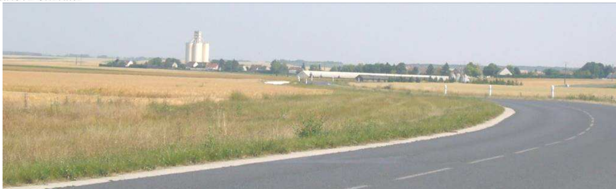
RD 74 dépourvue d'arbres d'alignement
