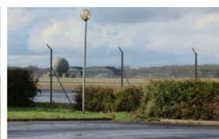
Le radar, un élément marqueur du paysage perceptible depuis l'ensemble du site
