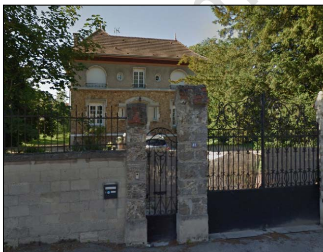
Maison anciennement appelée « Château Mouzin », rue Charles de Gaulle
