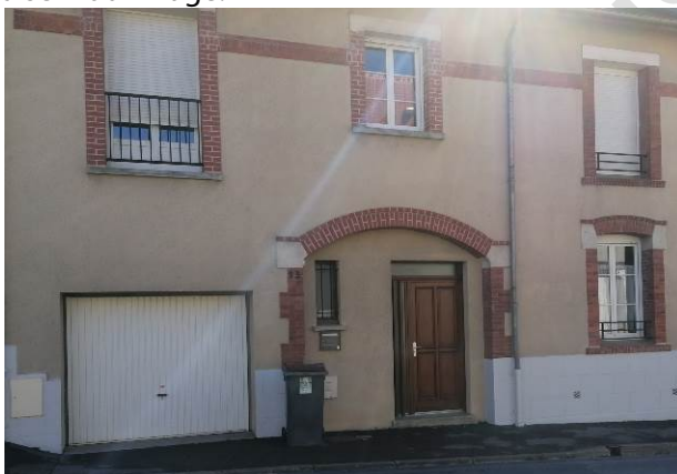
Exemple d'une transformation d'un porche en porte d'entrée (Source : BE Dumay)
