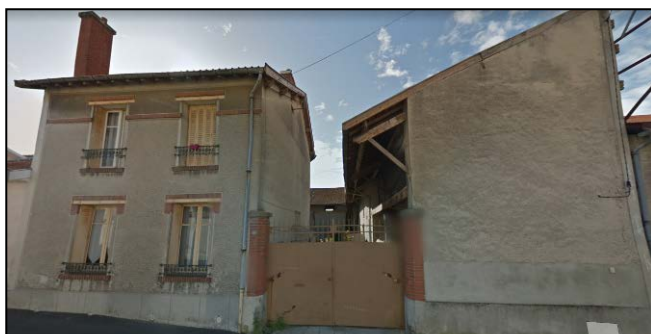
Exemple d'une ferme de bourg en U, rue du Cardinal Luçon
