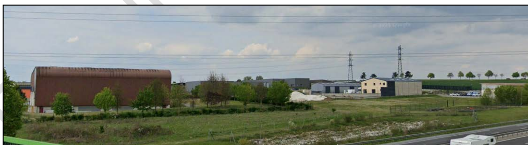
Vue de la zone des Didris depuis la route de Bétheny (Source : googlemaps.fr)
