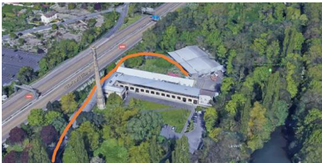
Accès au site
