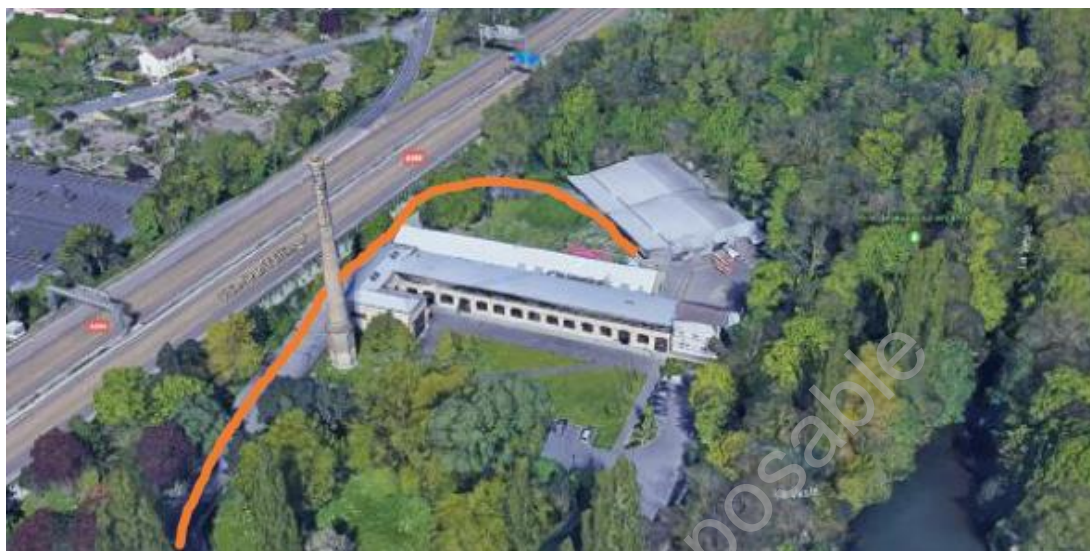
Accès au site
