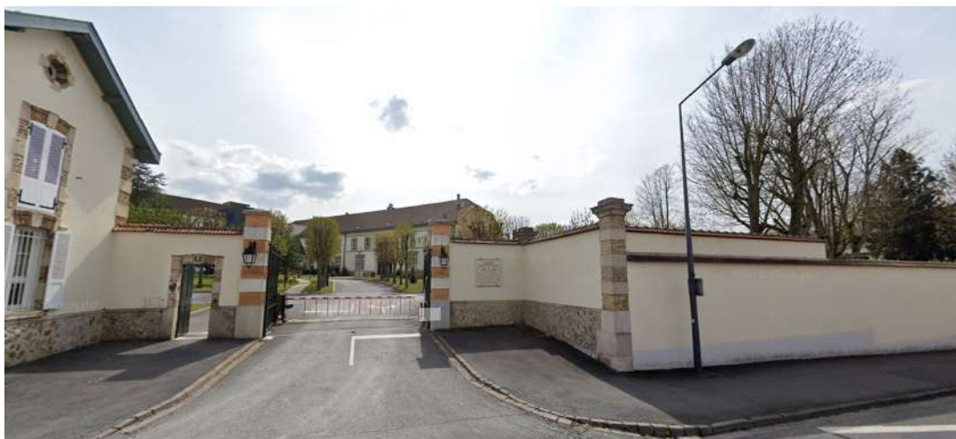
Figure 10 : Vue du site depuis son entrée rue des Crayères (Source : Google street map 2019)
