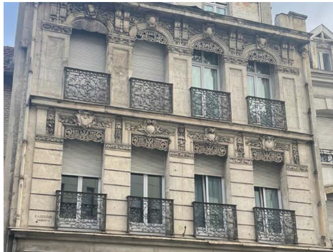
17 rue Gambetta (fin XIXe s.) E. LECLERE arch. à l'ancien alignement de la rue a conservé tous ces décors (lambrequins, garde-corps, ...)
