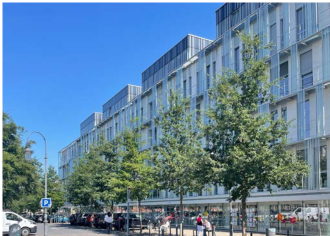
Réhabilitation de la Caserne Colbert, 2017, JM Jacquet arch.
