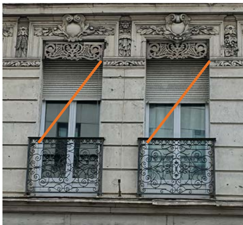
17 rue Gambetta Volets roulants PVC et menuiseries PVC sur un immeuble de la fin XIXème s.
