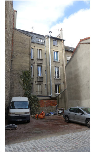
rue du Tambour
