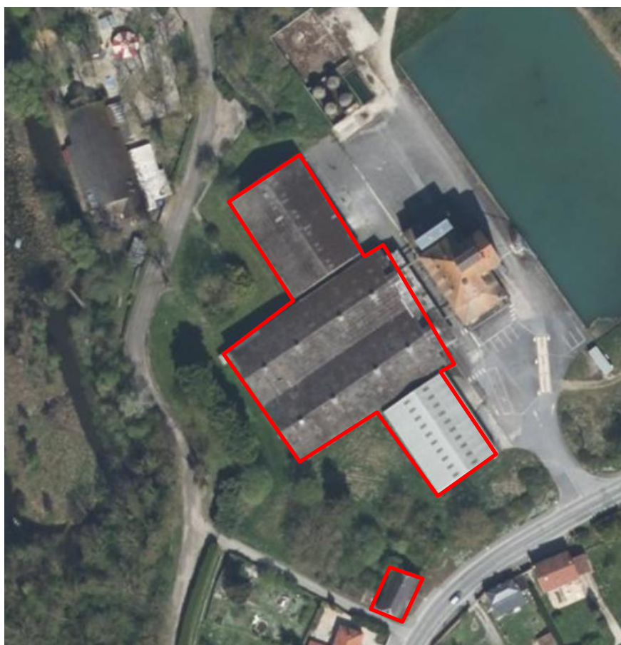
Photo aérienne des 4 bâtiments à réhabiliter
