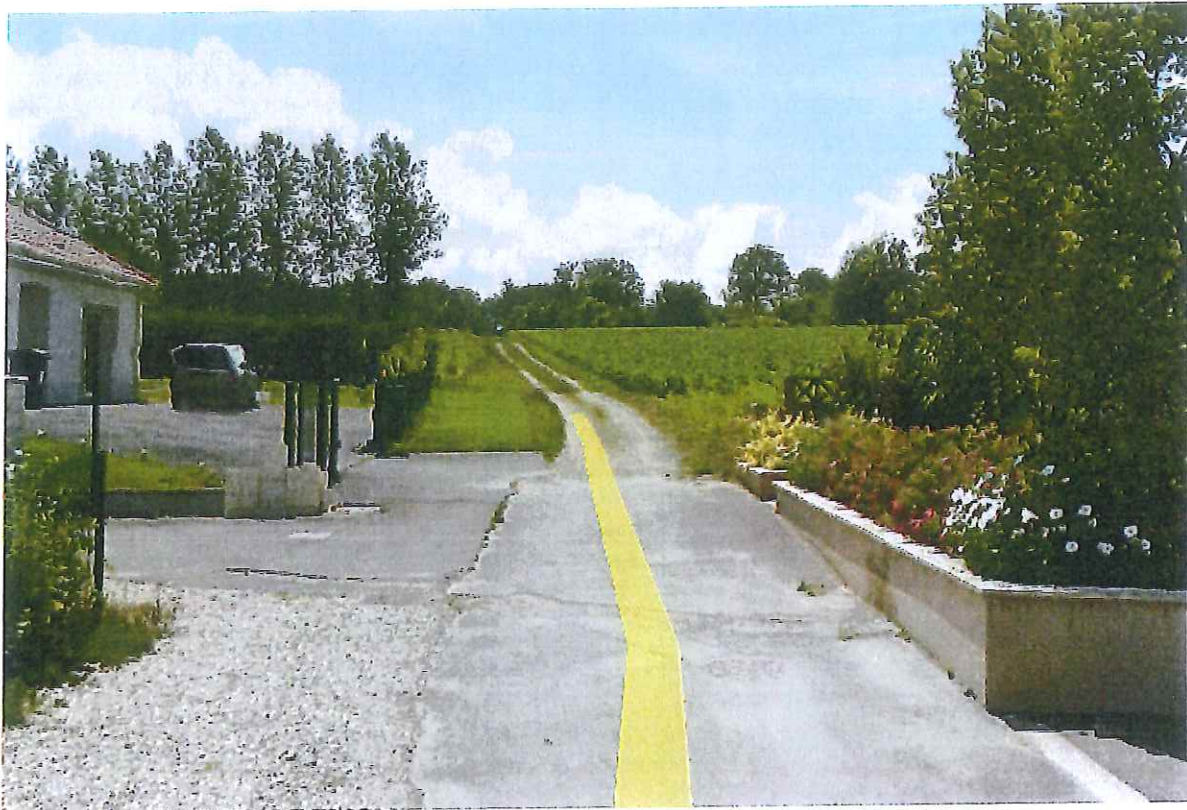
Photographie de la voirie concernée
