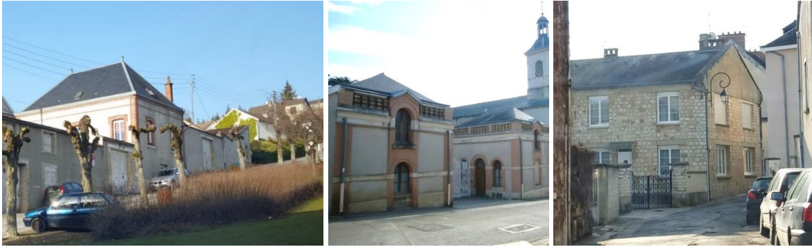
Bâti traditionnel du centre de Verzy
