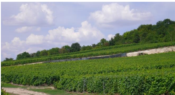
Banalisation du paysage avec une perte de qualité (mur de soutènement en tôle)
