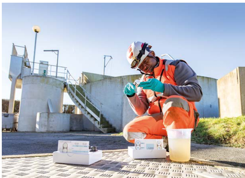
Environ 90 000 m 3 d'eaux usées sont traités par la station d'épuration de Beine-Nauroy.
