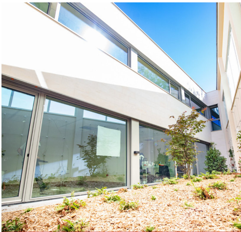
Après plus d'un an de travaux, place aux premières consultations dans les prochaines semaines.
