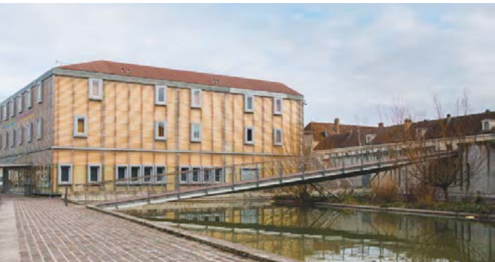
Résidence Les Courtines
